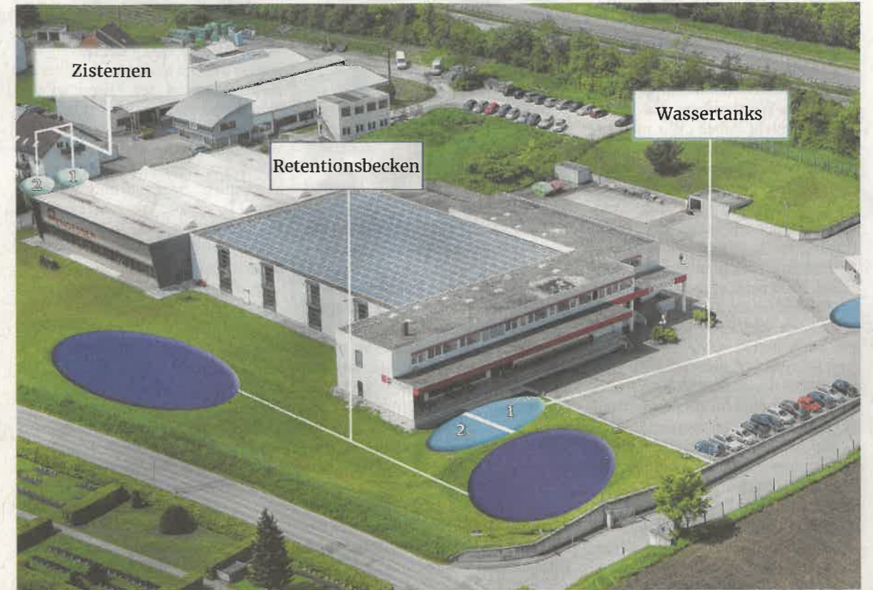
So verteilen sich die Wassertanks und -becken auf dem Firmengelände.
